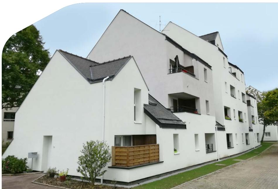
**LANVEUR (56)**. Des travaux d'isolation thermique ont été réalisés par l'extérieur sur 26 logements. Coût des travaux pour chaque logement : 39 000 €. L'étiquette énergétique est passée de la catégorie F à C après travaux avec une consommation divisée par deux et demi.
